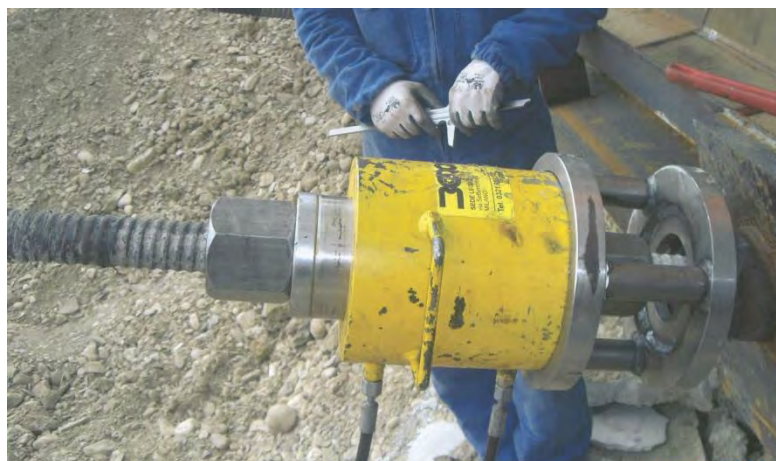
Prova di carico su barra di ancoraggio
