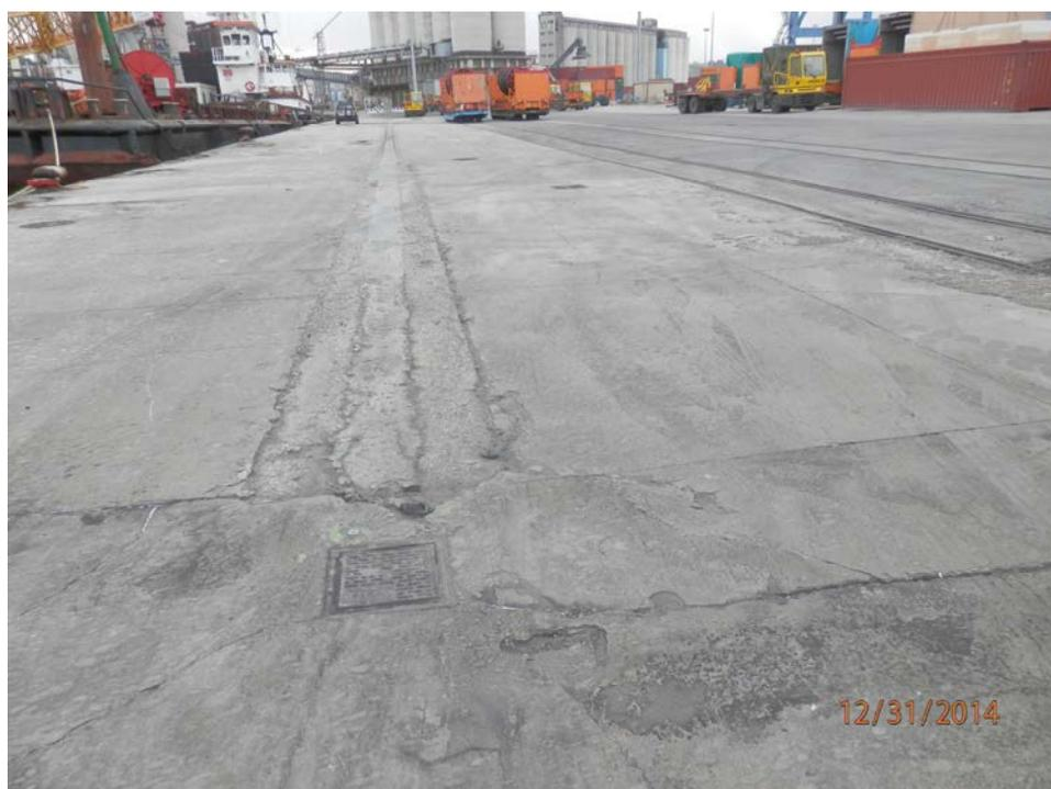
*Pavimentazione industriale a ridosso del ciglio della banchina d'ormeggio n. 22, con vecchia trave di fondazione per vie di corsa delle gru portuali*
