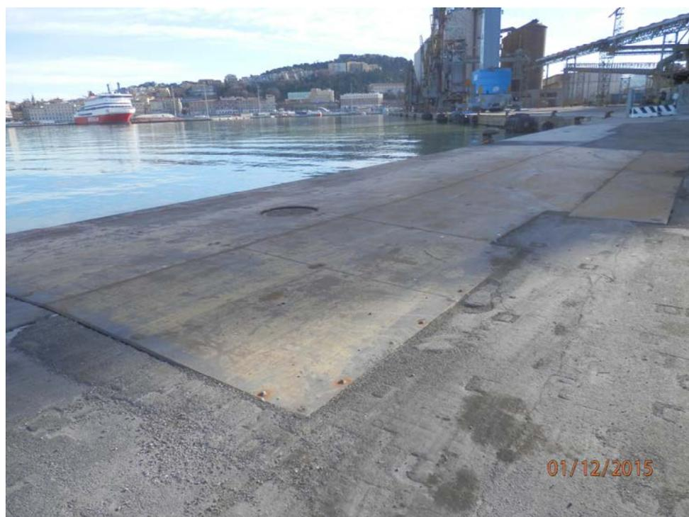
*Lamiera di rivestimento della pavimentazione nella radice della banchina*
